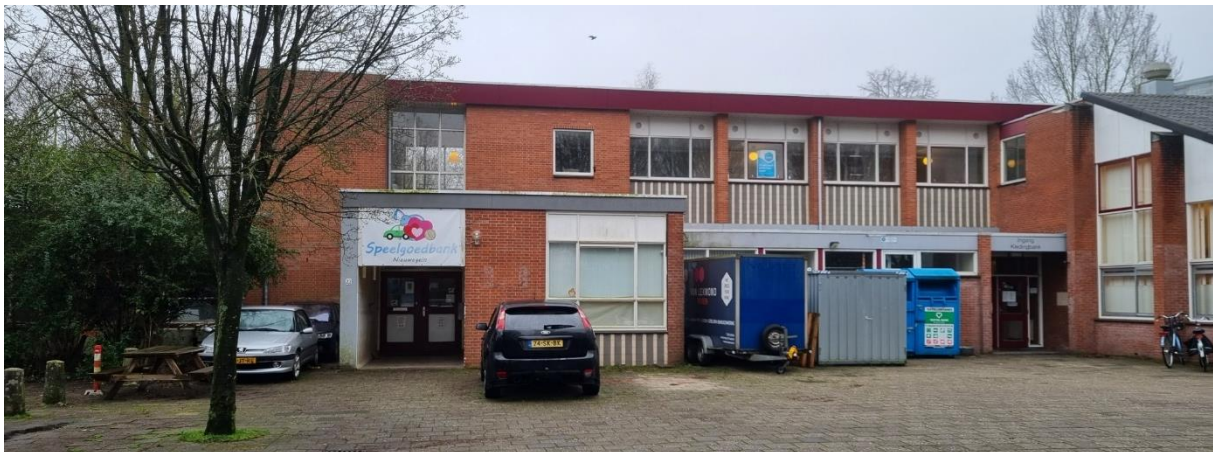
Afbeelding: Het schoolgebouw aan de Vredebestlaan
